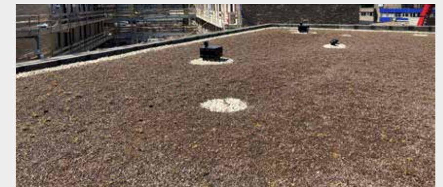
Haven Zuid sedumdak op blok C.
